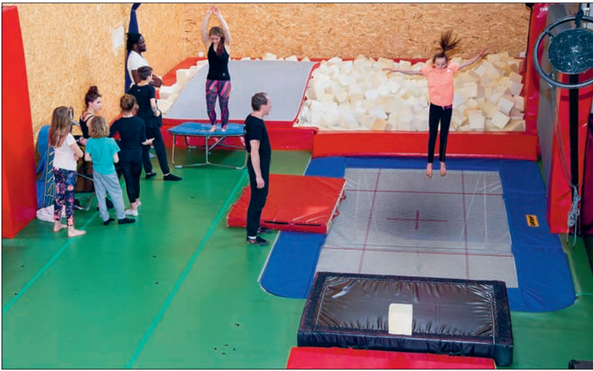
Il a fallu excaver le sol d'environ 1,50 mètre pour installer le trampoline et la fosse de réception.
